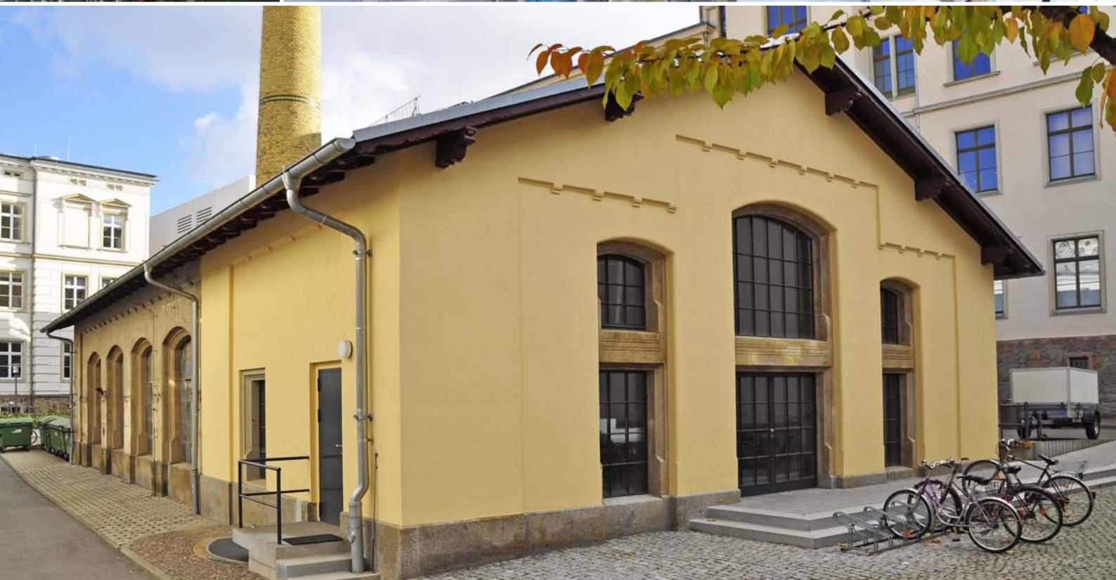
Altes Heizhaus. Uni Leipzig.
